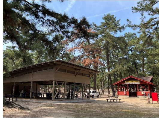
令和6年4月バーベキュー棟完成
